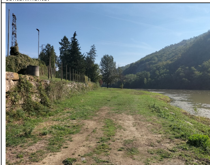
Sponda dell'Arno tra l'azienda "Dorin" ed il Fiume Arno. Presenza di muretto a secco a contenimento del terreno.
