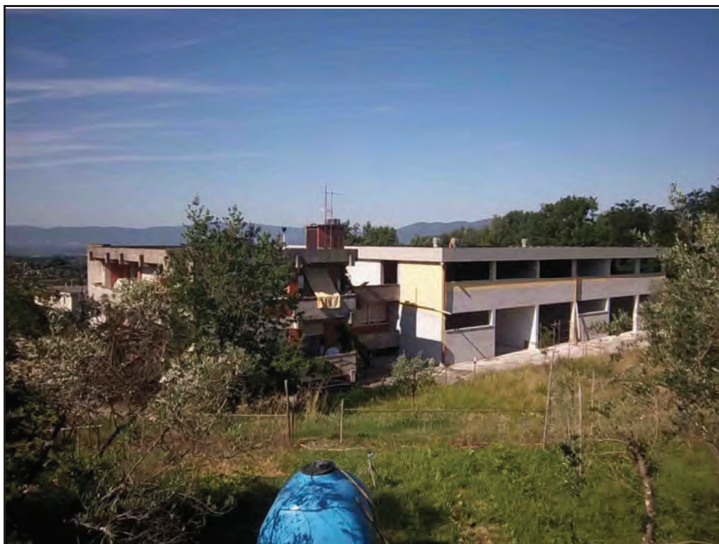
(Prospetto tergale stato attuale fabbricato oggetto di ristrutturazione)
