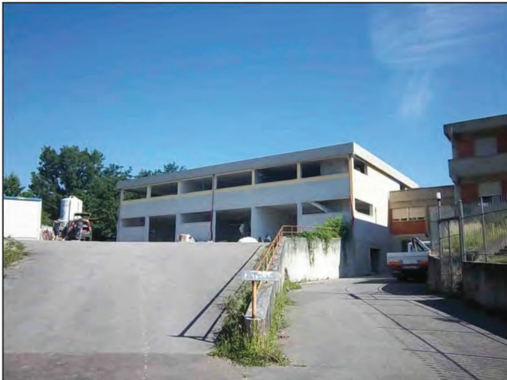
(Prospetto frontale stato attuale fabbricato oggetto di ristrutturazione)
