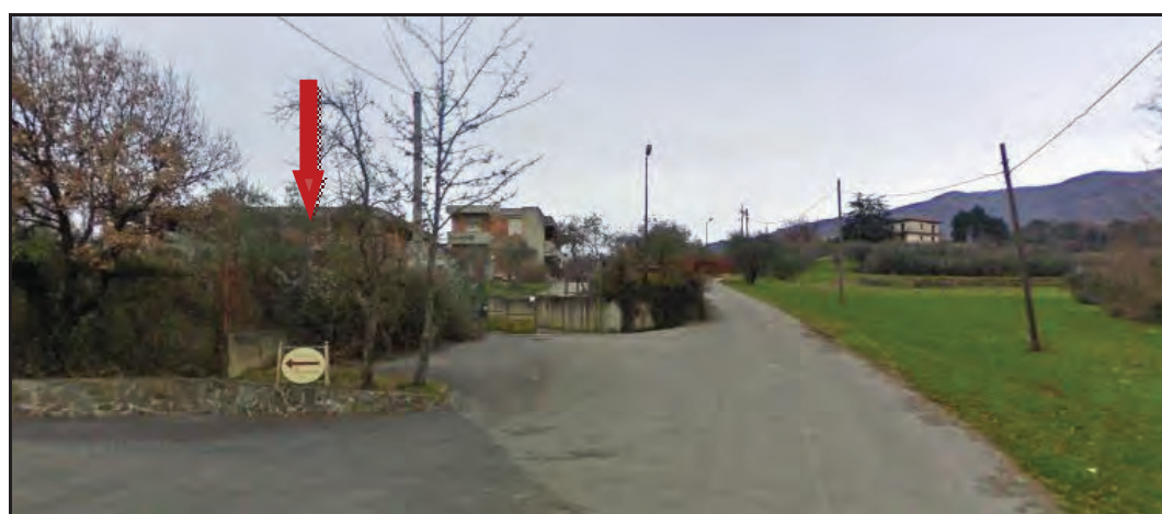
La freccia indica il fabbricato oggetto di intervento all'interno del quale verranno realizzati n. 6 appartamenti
