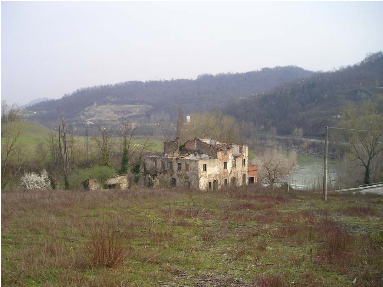
FOTO DEL FABBRICATO DALLA COLLINA DELLE "COSTERELLE"
