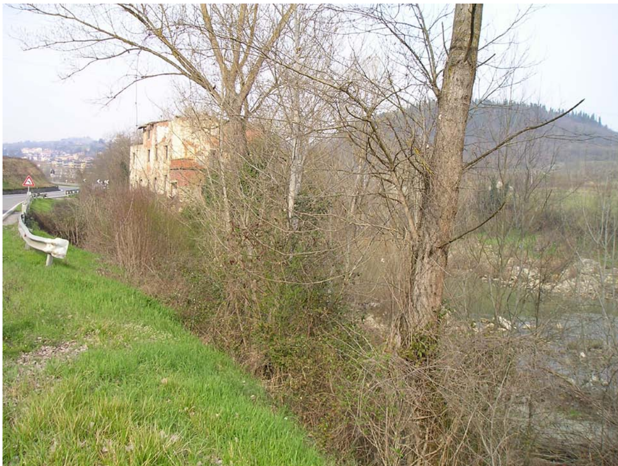
FOTO DELL'EDIFICIO CON VISTA DALLA S.R.69, DIREZIONE RISCAGGIO
