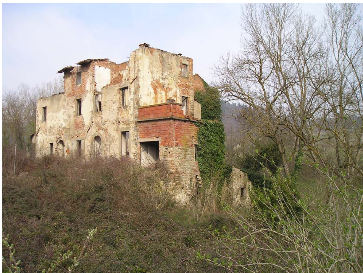
FOTO DELL'EDIFICIO CON VISTA DALLA S.R.69, LATO IN DIREZIONE DI RISCAGGIO
