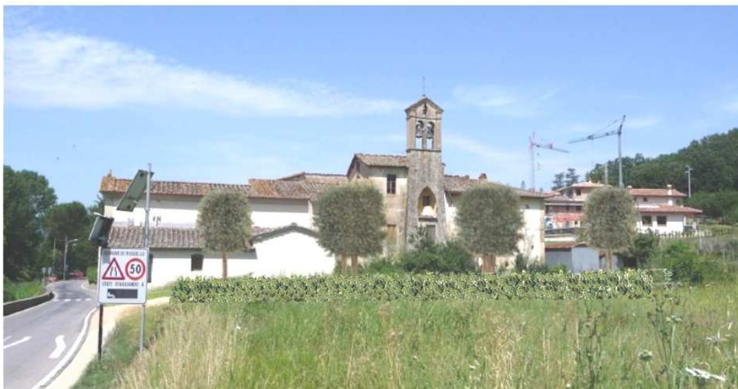
Realizzazione del parcheggio a servizio della Chiesa di S. Salvatore a Leccio
