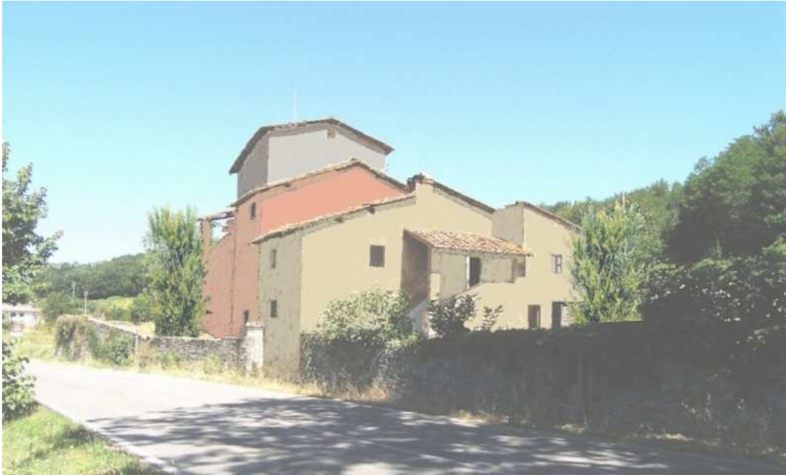
Vista del fabbricato dalla strada provinciale dopo gli interventi di ristrutturazione
